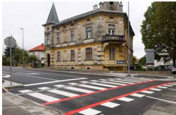
Zgledno urejen prehod na Cesti Staneta Žagarja omogoča varno prečkanje ceste pešcem in kolesarjem, poglobljeni robniki omogočajo prečkanje ljudem z invalidskimi in otroškimi vozički, taktilne oznake pa vodijo slepe in slabovidno varno čez cesto
