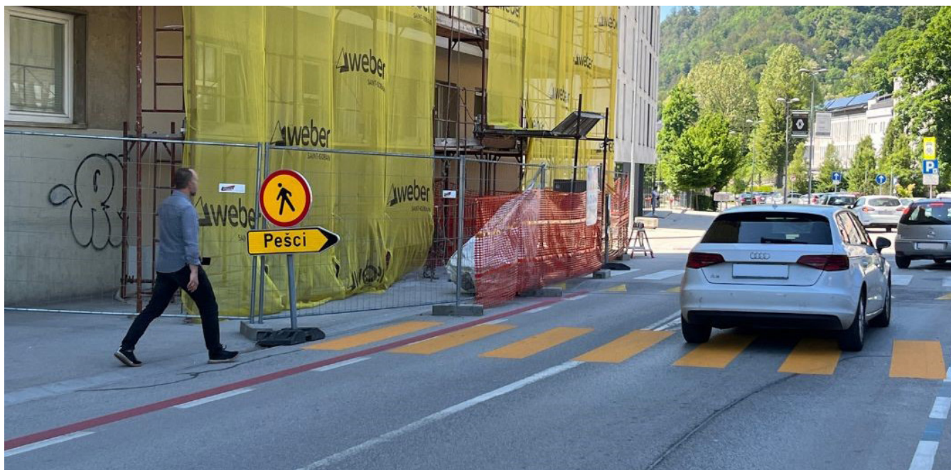
Začasen prehod za pešce na eni od cest v delu v Trbovljah. Avtorica fotografije: Urška Didovič
