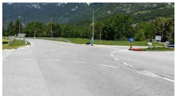
Slika 16, 17: Primer prometnih površin, kjer hodniki ali prehodi za pešce niso urejeni
