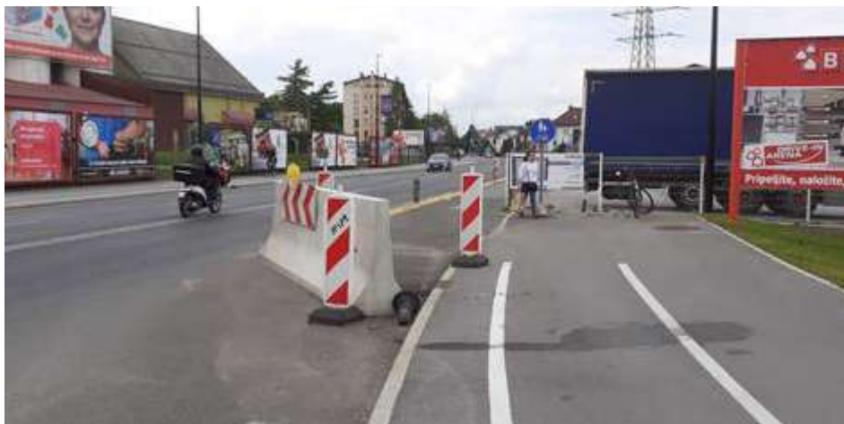
>> Prikaz ureditve poti za pešce in kolesarje ob začasnih zapori
