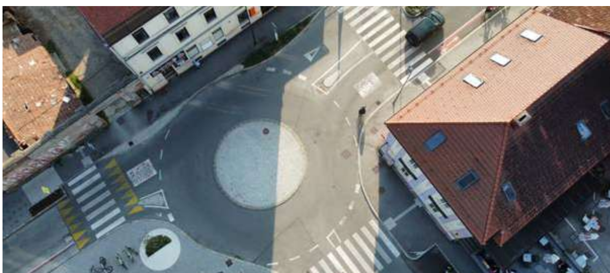
>> Dva primera mini krožnih križišč na ulici kneza Koclja in na Koroški cesti v Mariboru
