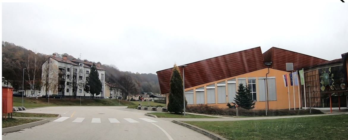
Slika: Stojala za kolesa ob osnovni šoli Majšperk
