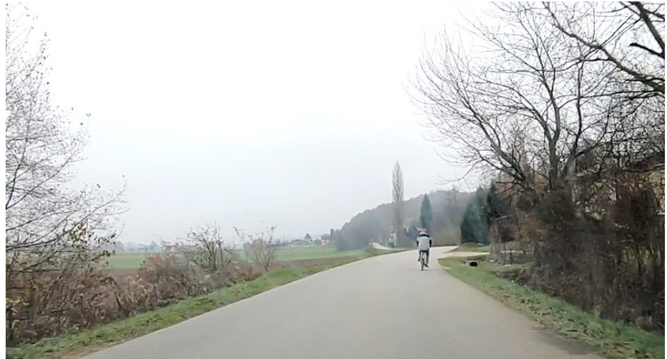
Slika: Podložje - Kolesar na cestišču
