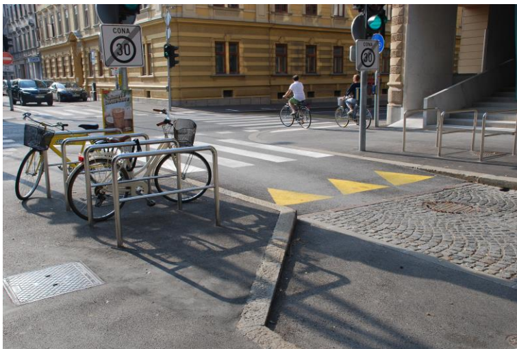
Primer ustrezne izvedbe ledvičke in prehoda na dvignjenem platoju v Ljubljani
