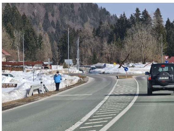
Cesta brez površin za pešce v Ratečah
