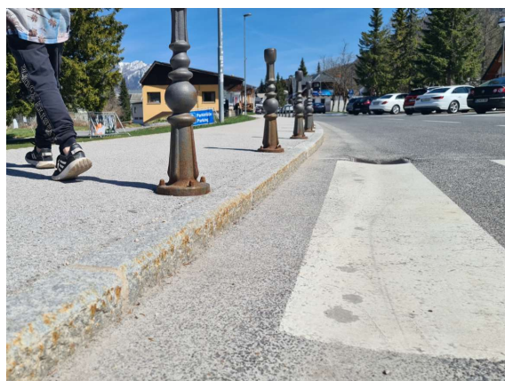
Primer pločnika brez znižanega robnika
