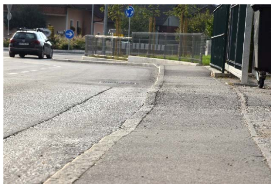
Slika: Pločnik s številnimi zaporednimi spusti na nivo vozišča inuvozi na parcele stavb
