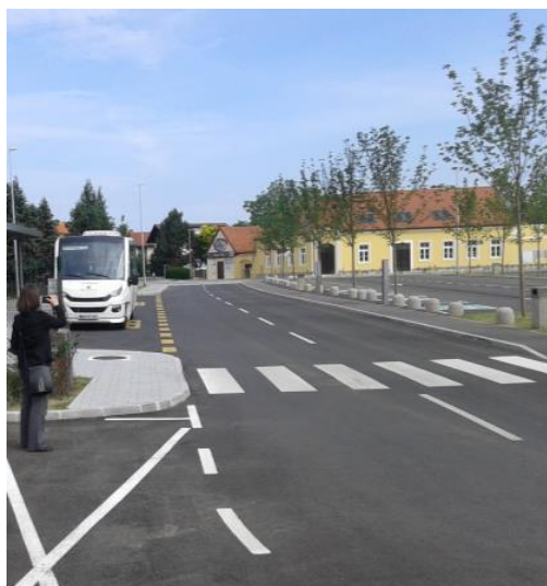
Slika 3: Postajališče JPP ob vhodu v P+R, vzdolž parkirišč (P+R Ptuj); primer dobre prakse umeščanja postajališča v neposredni bližini parkirišča.
