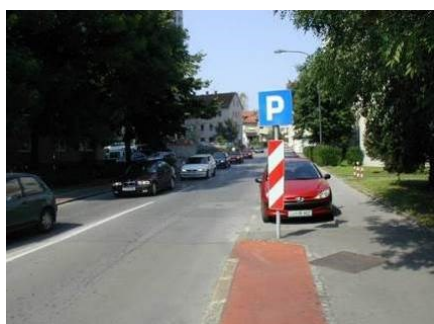
Slika 19: Primera neustreznega prehoda (zaključka) kolesarske steze (preoster prehod - prehod na prekratki razdalji, na prometnem pasu za motorna vozila ni talnih oznak, ki bi voznika usmerila stran od roba ceste, voznik ni opozorjen na kolesarja) (vir: kolesarji.org, Lep et al.)
