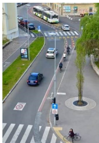
Slika 43: Stanje po preureditvi Trubarjeve ceste v Ljubljani. Pred preureditvijo je bila ulica dvosmerna cesta, s spremembo prometnega režima v enosmerno ulico je nastal prostor za zelenico in kolesarski pas v protitično smer (Vir: Arhiv MOL)
