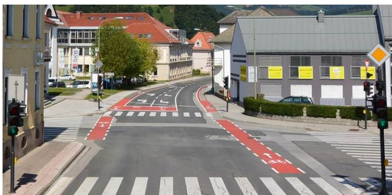
Slika 14: Izvedba "Čakalne površine za kolesarje" oz. t.i. "Cycling box-a" v kombinaciji s kolesarskih pasom v Slovenj Gradcu (Arhiv MO Slovenj Gradec)
