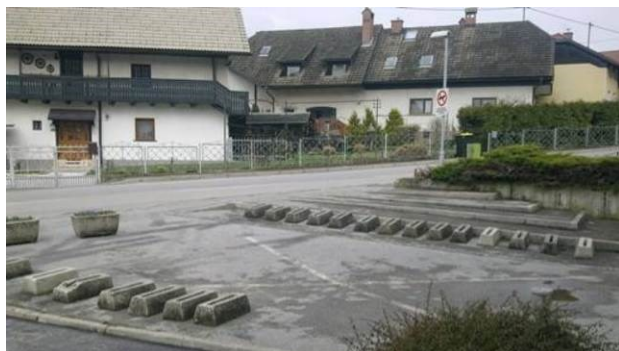
Slika 88: Neprimerna betonska stojala, ki ne omogočajo niti priklapa kolesa (Gregor Steklačič)
