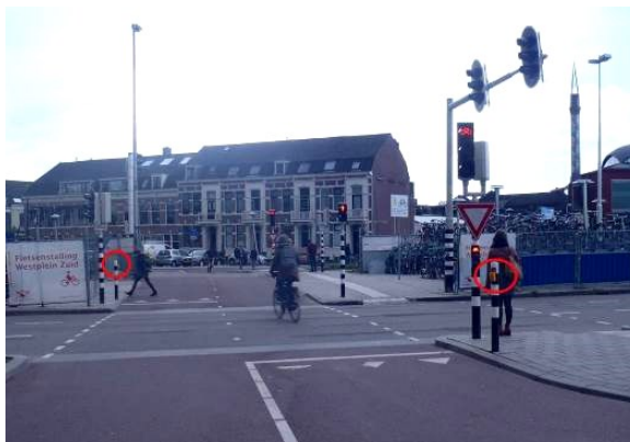
Slika 81: Stikalo za skrajšanje intervala zelene luči prednostne ceste na dosegu ob kolesarski površini v Utrechtu (Polona Demšar Mitrović)
