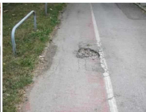
Slika 101: Slabo vzdrževana barva in zgornji ustroj
